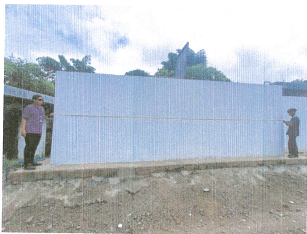
โครงการก่อสร้างถังเก็บน้ำคอนกรีตเสริมเหล็ก บ้านป่าแดงใหม่ หมู่ที่ ๒๑
