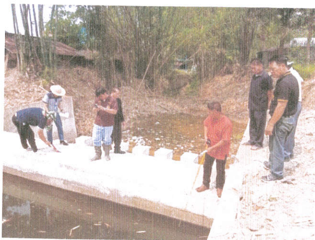
โครงการก่อสร้างฝายคอนกรีตเสริมเหล็ก ห้วยน้ำแพร่ จุดที่ ๑ บ้านน้ำแพร่ใต้ หมู่ที่ ๑๙
