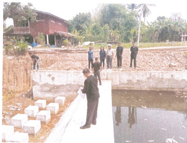
โครงการก่อสร้างฝายคอนกรีตเสริมเหล็ก ห้วยน้ำแพร่ จุดที่ ๒ บ้านน้ำแพร่ใต้ หมู่ที่ ๑๙
