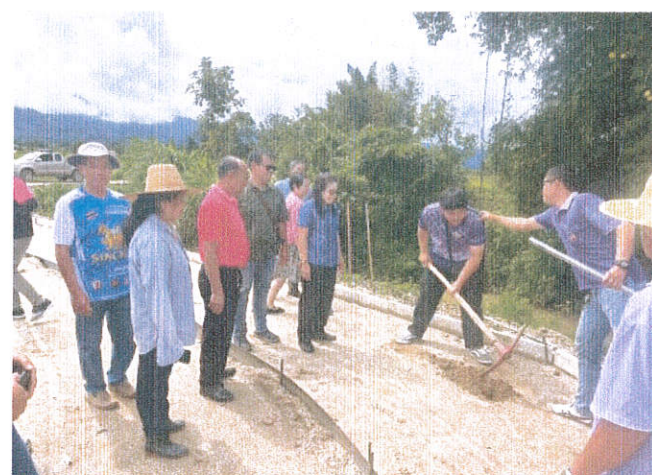
ตรวจสอบการลงลูกรังของผู้รับเหมาก่อนทำถนนคอนกรีตเสริมเหล็ก ถนนสายห้วยหมาใน
