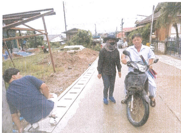
โครงการก่อสร้างรางระบายน้ำ รูปตัวยู ชนิดมีฝาปิด ขอย ๔ บ้านห้วยหลวงเหนือ หมู่ที่ ๕
